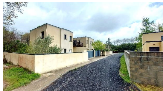
Maison sur 1 étage avec toit plat, murs en parpaings crépis de la même couleur que l'habitation, ambiance assez minérale
