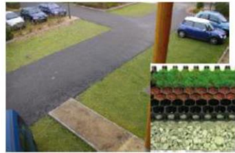
parking dalles alvéolaires enherbées
