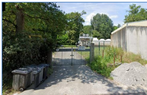
Station d'épuration actuelle
