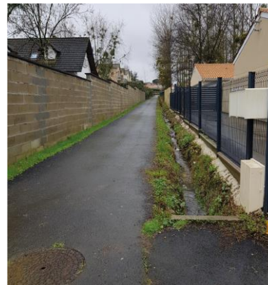
Canalisation de l'eau tendant à accentuer le débit de l'eau
