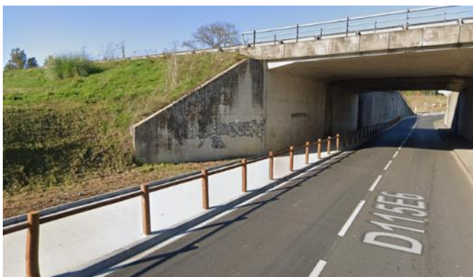
Aménagement espace public sécurisé pour traverser la RN 89
