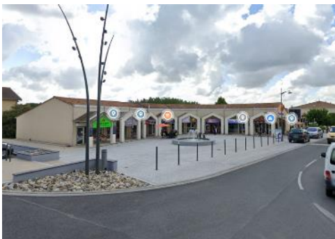
La place centrale accueille des petits commerces en face de l'église et de la mairie.
