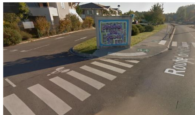
Aménagement espace public piéton et vélo (Rte de la Chaise)
