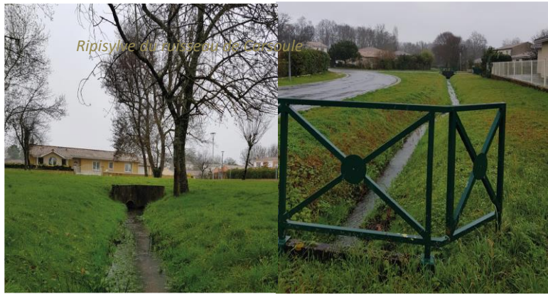
Artificialisation des tracés et des berges des fossés récupérateurs d'eaux, Impasse de l'Aubarède
