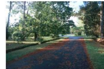
voirie et fossés latéraux
