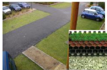
parking dalles alvéolaires enherbées
